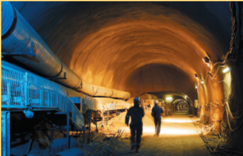
– Trabajos de instalación del acelerador LHC, cuya puesta en marcha se espera para 2007
