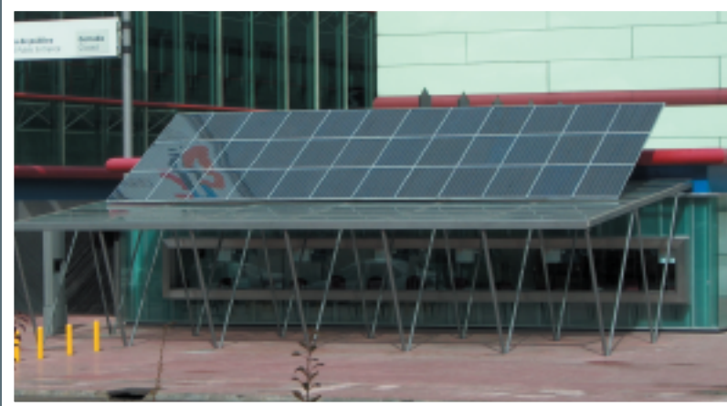
→ Placas solares en los exteriores del Recinto Ferial de IFEMA
