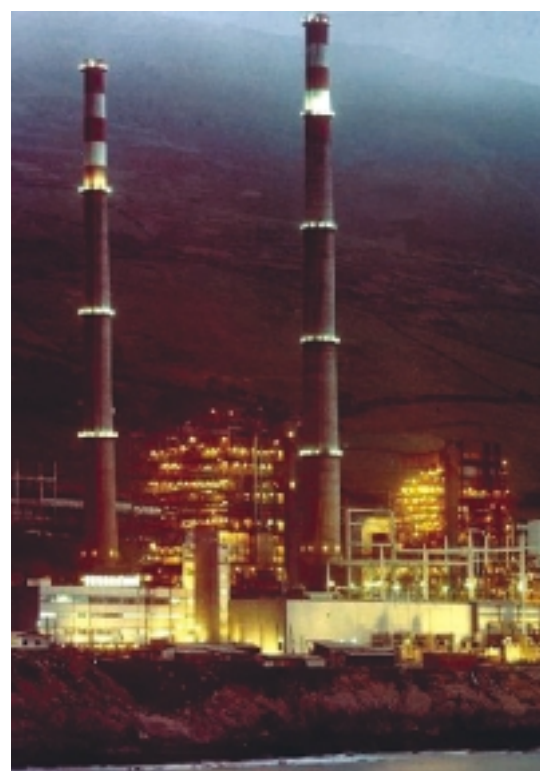
Central térmica de Santurce
