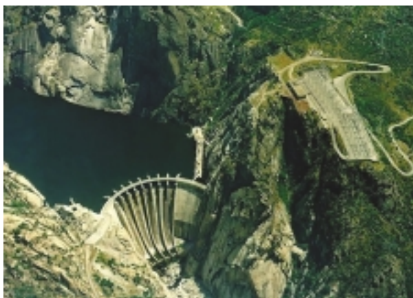
Presa de Aldeadávila (foto cedida por UNESA).
